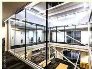
La nouvelle génération de cloisons vitrées grande hauteur Promat®-Systemglas F1, atteint des sommets en termes de dimensions avec des performances haute résistance au feu, grâce à leurs propriétés mécaniques
