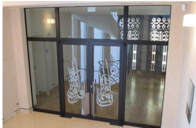
Ambassade d'Irak à Paris (75) : vitrages de protection incendie Stop'Feu® CF 1h Riou Glass et impression sur film ©Riou Glass
